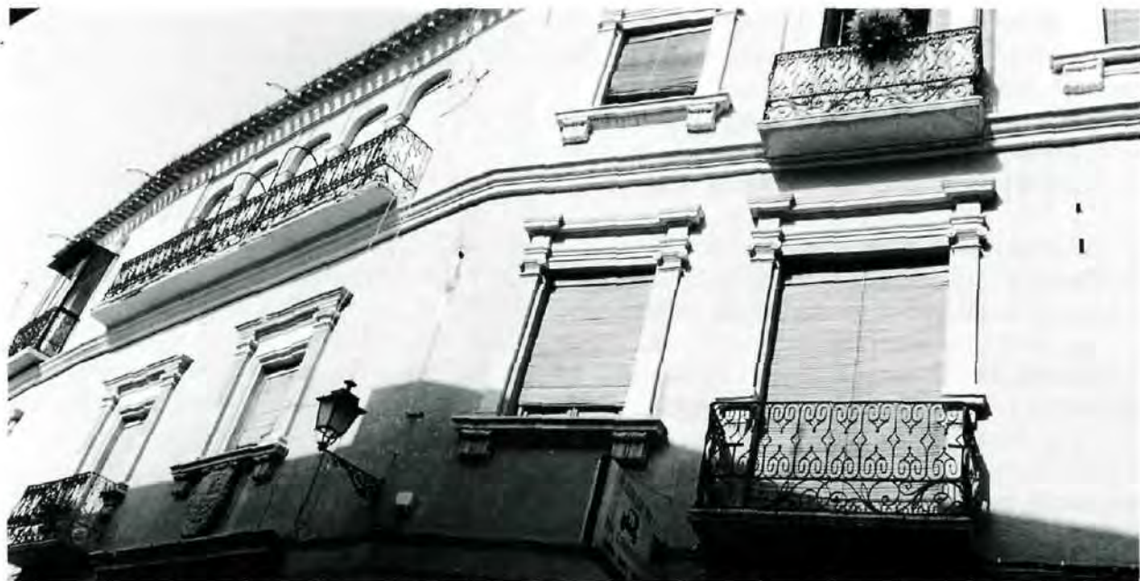
Vista actual de la parte superior de la Casa de los Irurita.
