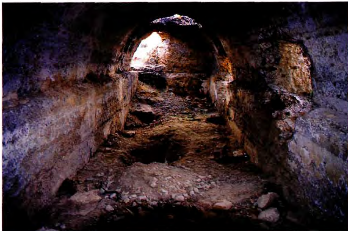
Lámina 6.- Aljibe 1. Se aprecian tres de las aberturas practicadas en los muros para su reutilización una vez perdida su funcionalidad original.
