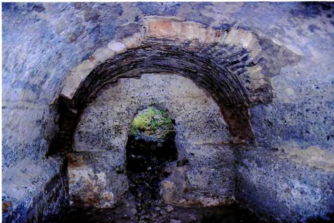
Lámina 5.- Aljibe 1. Detalle de la cimbra de ladrillo.
