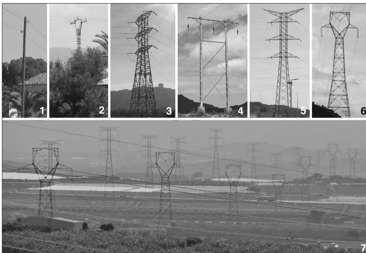
Lámina 7: Tipos de apoyos de líneas a diferente voltaje en el entorno de Lorca. De izquierda a derecha: 15 kV (Pozo Higuera), 25 kV (Tiata), 66 kV (Lorca-Cuartel), 66 kV (Lorca-Águilas), 132 kV (Barranco Hondo) y 400 kV (La Asomada). Abajo, corredor eléctrico al sur de la ciudad, subestación de Carril, con las líneas «Rocamora» y «La Asomada». EL AUTOR.
