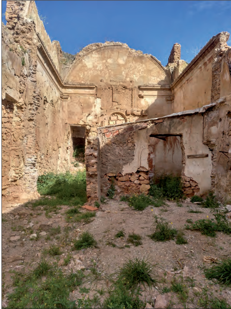
Lámina 7. Estado de la ermita (2016). Vista interior. Fuente: Fotografía del autor.
