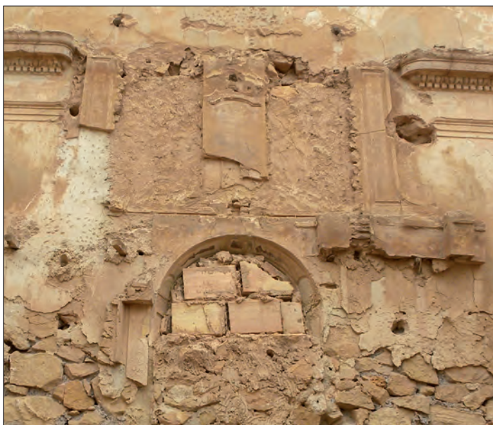
Lámina 11. Izquierda: detalles de la interrupción de la cornisa el s. XVII y restos del altar en estuco del s. XVIII. Derecha: esquema de composición de este. Fuente: Fotografía del autor. Esquema de Patrimonio Inteligente.
