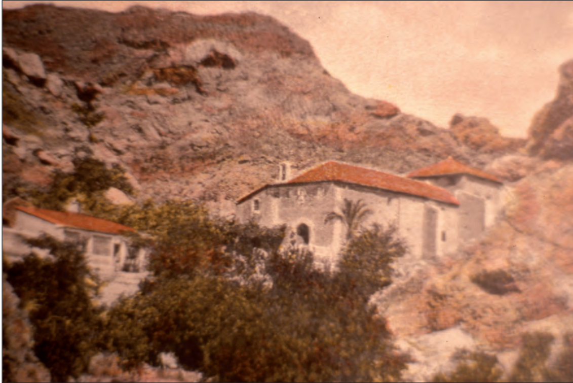
Lámina 2. Imagen coloreada de la ermita de San Lázaro. Fuente: Archivo Municipal de Lorca [AML]
