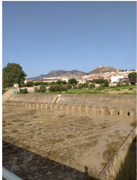
Figura 4. Actual azud con el sangrador o boquera que el catedrático de Geografía Antonio Gil Olcina califica como de «Gran Boquerón». La casilla de la izquierda del azud contiene los mecanismos que abren dos compuertas para sangrar el río encaminando su agua a través de la rambla de Tiata hacia la huerta.
