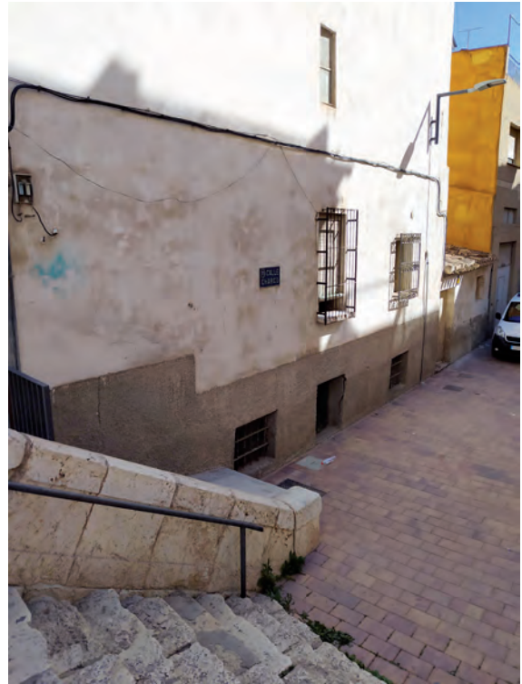
Figura 2. Escaleras hacia el «Charco», desde la bajada del puente.
