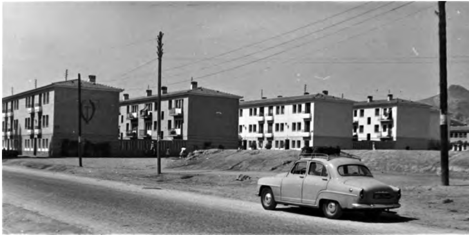
Figura 7. Las Casas Baratas de Lorca en 1962. La elección del bloque de doble crujía permite configurar viviendas exteriores bien ventiladas y aireadas en las zonas de ensanche (A.M.L.)
