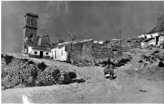
Figura 27. Barrio de San Pedro (1978). Viviendas en mal estado junto a la derruida iglesia (A.M.L. Fondo Valera).
