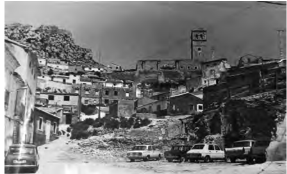
Figura 29. Barrio de Santa María (1978). La densificación que se produce en los Barrios Altos de Lorca tiene su reflejo en la ocupación de espacios no urbanizados y en la elevación de planta o ampliación de las viviendas, muchas veces sin control municipal (A.M.L. Fondo Valera).
