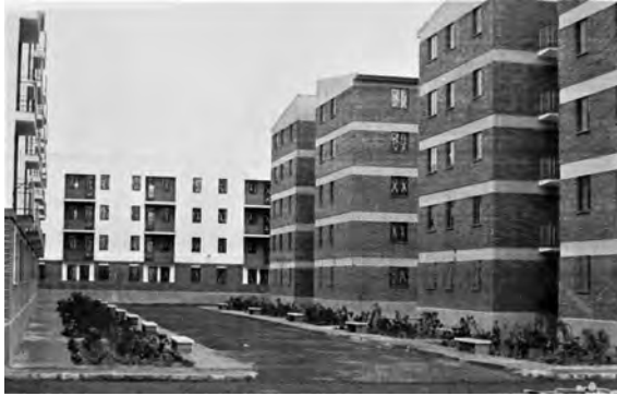
Figura 21. Grupo de 94 viviendas Santa María del Alcázar (1964). Vista del complejo desde el Paseo de San Diego con los dos tipos de edificios empleados (Archivo General de la Región de Murcia).
