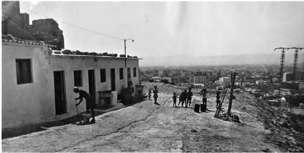
Figura 30. Viviendas solidarias en San Pedro (1978). Vista de las viviendas para damnificados por las lluvias torrenciales de 1969 junto al atrio de la iglesia (A.M.L. Fondo Valera).
