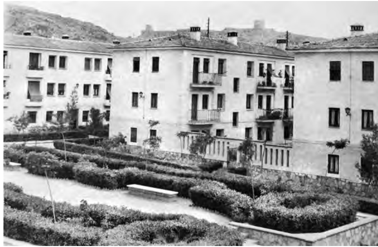
Figura 9. Grupo de 178 viviendas Ntra. Sra. la Real de las Huertas en 1958. Plaza central Virgen del Alcázar. Disposición paralela de los edificios, con patios interiores cerrados y zonas ajardinadas (A.M.L. Foto Matrán).
