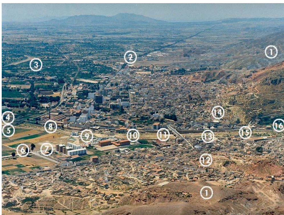
FIG. 10. ESTADO DEL CAUCE DEL GUADALENTÍN A SU PASO POR LORCA EN 1967
