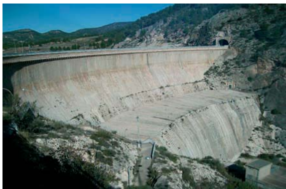
Vista del pantano de Valdeinfierno, aterrado por la deforestación de su cuenca, en el que se aprecia la presa original y el recrecimiento de 1897. Foto: J. David Romera Franco.
