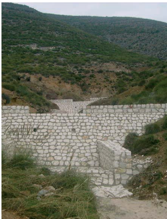
La corrección de vertientes en la cuenca del Guadalentín es relativamente reciente y muy necesaria para evitar la erosión remontante. Presas en el cerro de La Paca. Foto: J. David Romera Franco.
