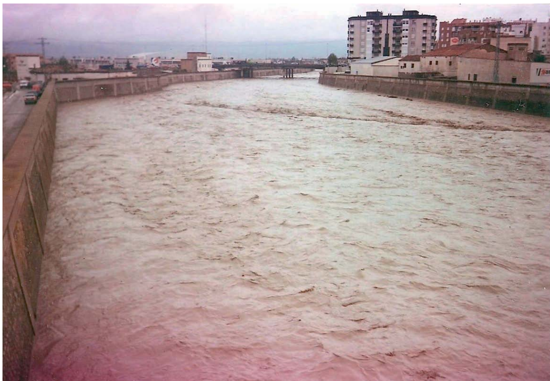
Obsérvese como la lámina de agua en esta crecida de 1997 aumenta su altura junto al puente de San Diego, por el 'efecto embudo' que provoca el estrechamiento del cauce. Queda más claro si se observa la evolución de la altura de las aguas siguiendo los muros de canalización. Foto: J. D. Romera Franco.
