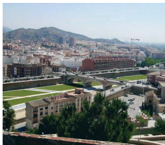
Canalización del río Guadalentín a su paso por la ciudad para defensa de la población. Foto: J. David Romera Franco.
