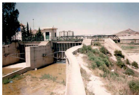
Vista de las compuertas de los Sangradores actuales, ahora emplazados en la derivación de Tiata junto al nuevo azud. Foto: J. David Romera Franco.
