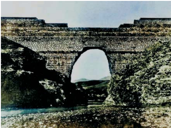
Espectacular fotograbado del estado de la presa de Puentes tras su rotura en abril de 1802. Foto: Archivo Histórico Municipal de Lorca.
