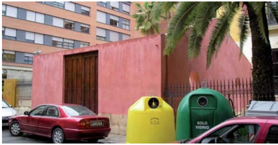
Estado tras la intervención.
