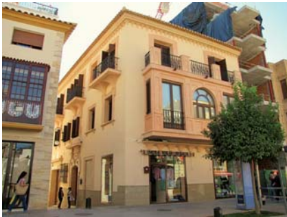
Edificio calle Nogalte (1957). Calle Nogalte esquina a Campoamor.
