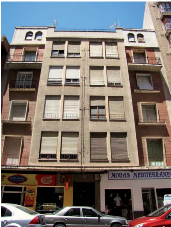
Edificio Avda. Juan Carlos I (1958). Avda. Juan Carlos I, 73.
