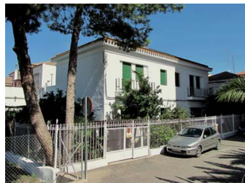
Barrio Casas del Banco (1956). Avda. de Cervantes (Ctra. de Águilas).
