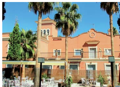
Vivienda en Alamedas (1952). Alameda Corregidor La-puente.
