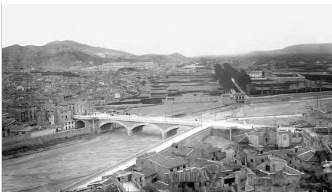
Puente de piedra sobre el río Guadalentín (AML, P. Menchón, h. 1929)
