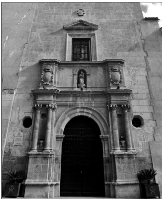
Fachada de San Francisco. A la derecha se aprecia el machón de piedra, hoy residual, que sustentaba el empuje de los sillares por lado Oeste.
