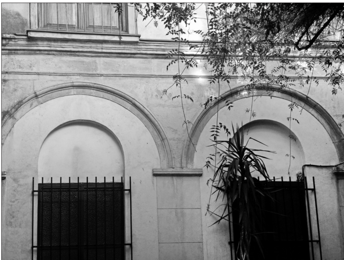
Vista parcial de dos arcadas del claustro de 1658 cegadas en su totalidad por sucesivas reformas.
