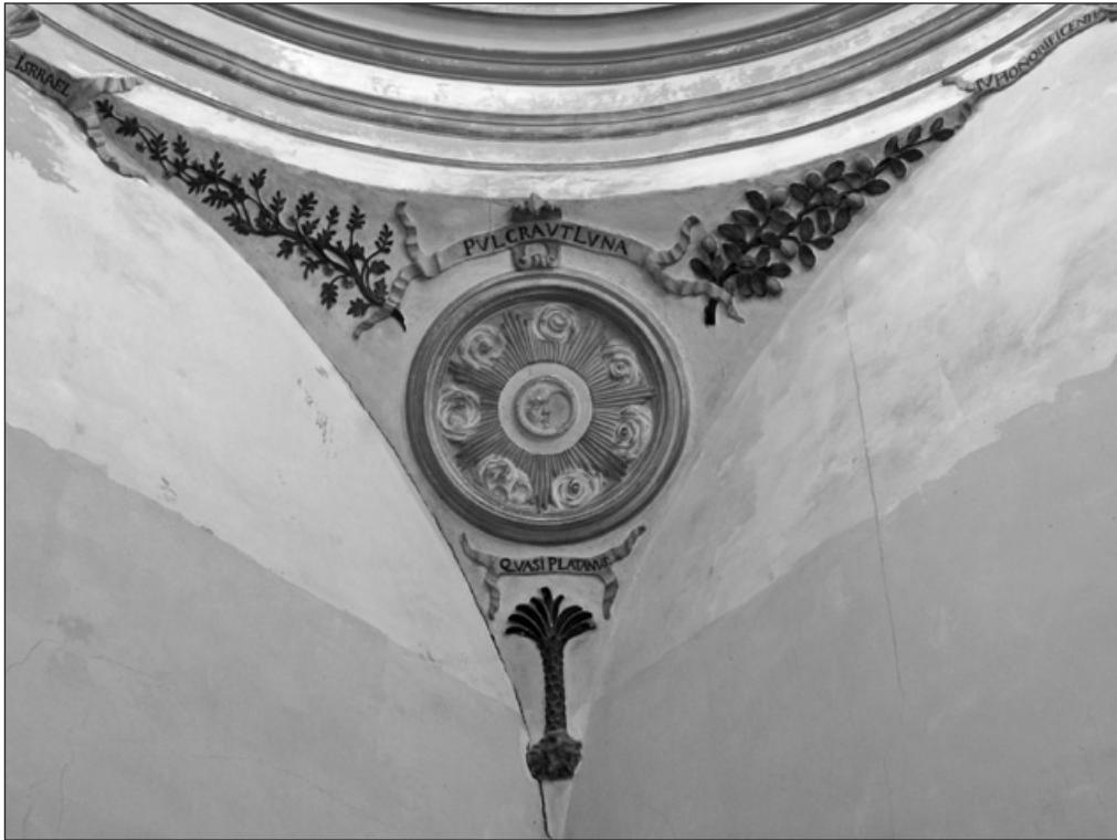
Detalle de pechina de la escalera de la Tota Pulchra.
