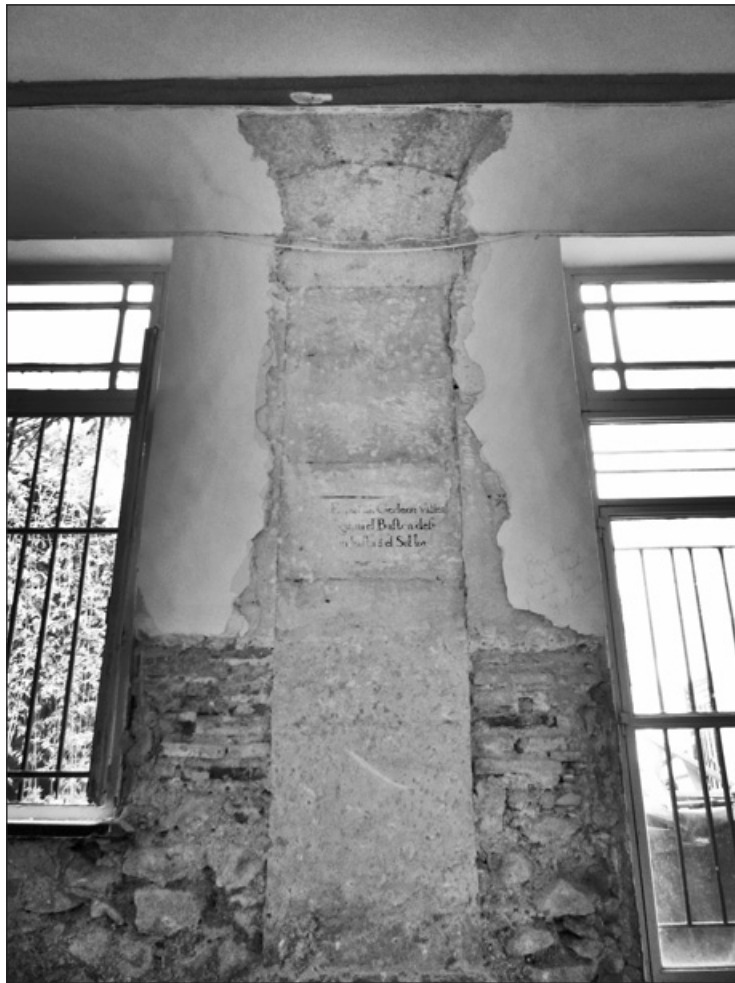
Pilar de piedra del claustro del siglo XVII en el que se aprecia el estrechamiento de los arcos practicado en la década de 1730 y restos de las pinturas decorativas que se añadieron.
