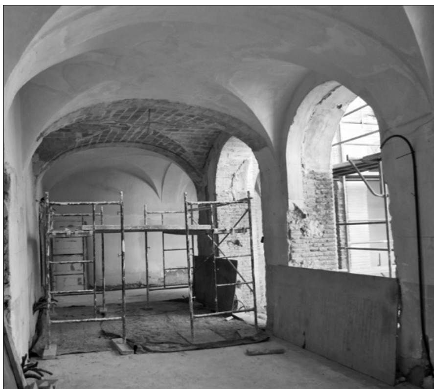
Proceso de restauración de uno de los corredores del claustro del siglo XVIII.
