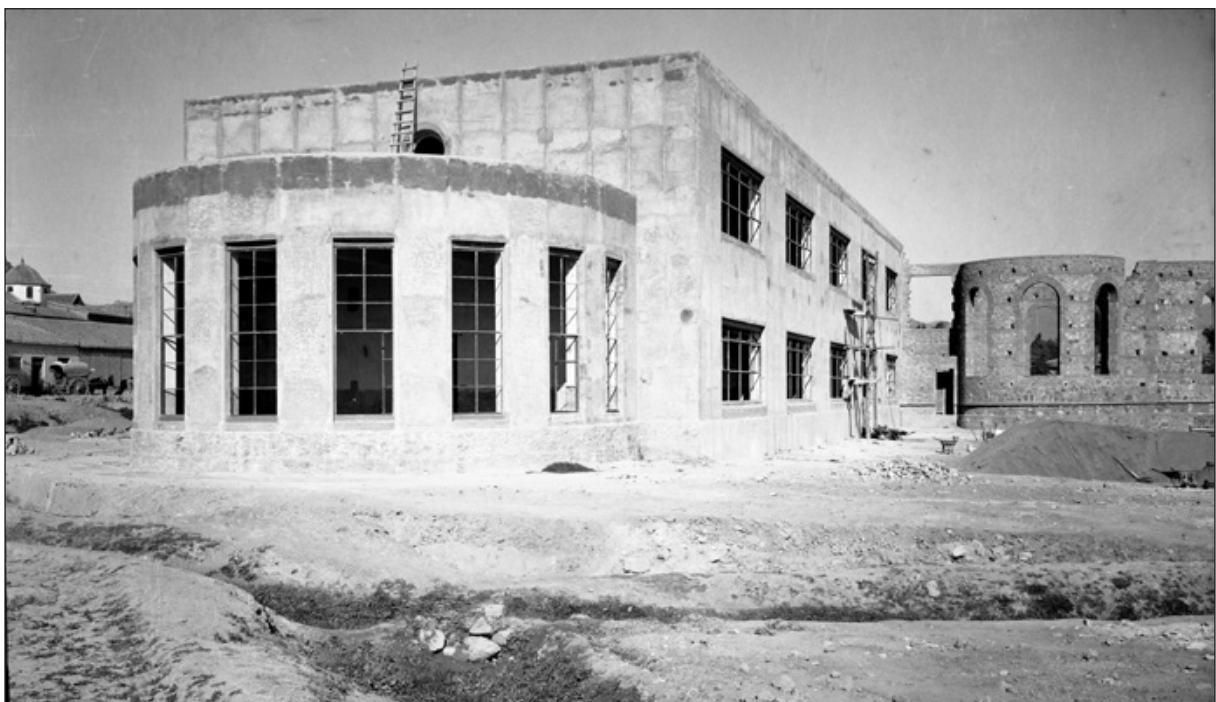
Construcción del instituto [AML. P. Menchón. 1943].
